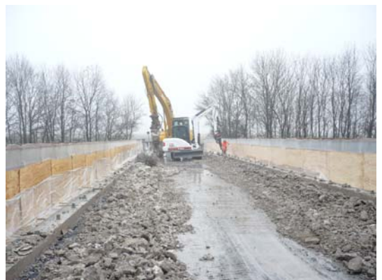
Abriss Kappe Überführungsbauwerk A44
