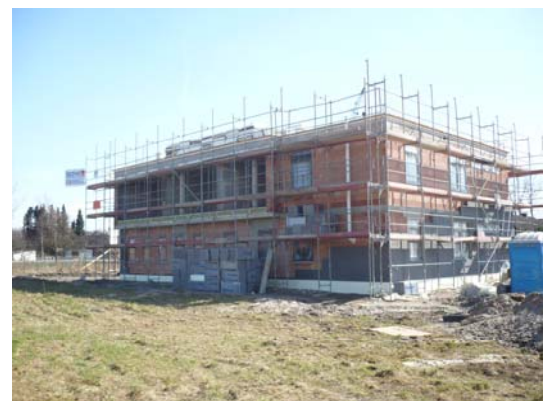
Eingerüsteter Neubau eines Bürogebäudes
