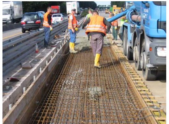
Talbrücke Ostöninger Bach im Zuge der A44
