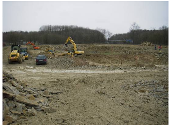
Erdarbeiten am RKB und RBF
