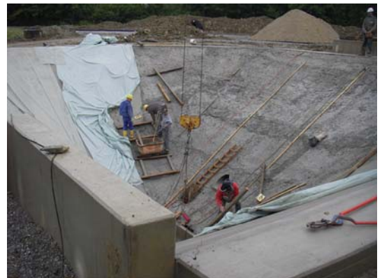
Betonarbeiten am Regenklärbecken
